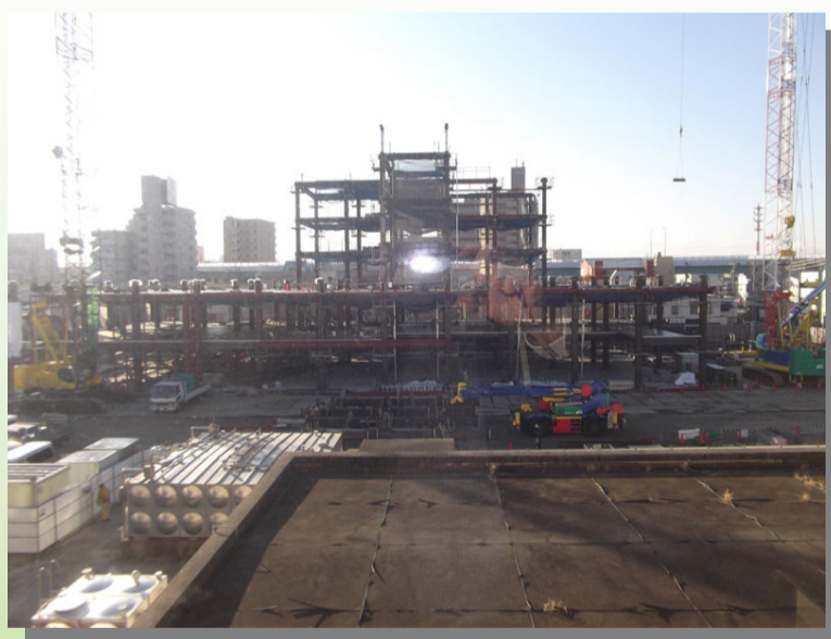
現在建設中の新偕行会城西病院
